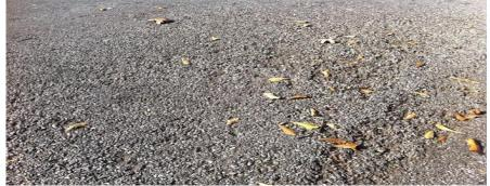
Fig. Raveling (very porous asphalt)
